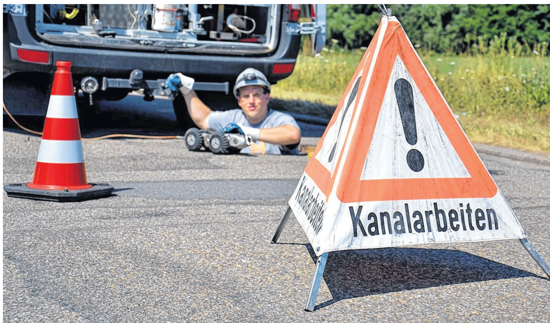
In die Tiefe: Alexander Kreis fühlt sich zu seiner Arbeit als Kanalreiniger berufen. Er sorgt für frei Rohre und eine saubere Kanalisation in und um Bad Mergentheim. FOTOS: CAROLIN LEMUTH
